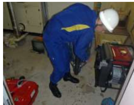
非常用発電機を運び出すようす
