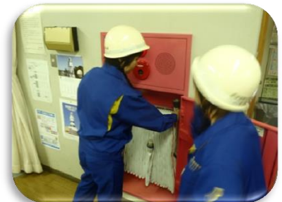
消火栓の位置等の確認
